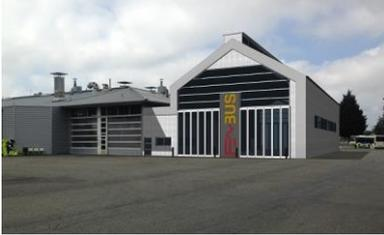
L'atelier a été conçu avec une structure adaptée à l'usage de L'H2. Les zones de risques d'explosivité (ATEX) et les équipements sont adaptés aux FEBUS à Hydrogène. Des études de risques et de dangers ont permis de prendre en compte toutes les questions de sécurité.
